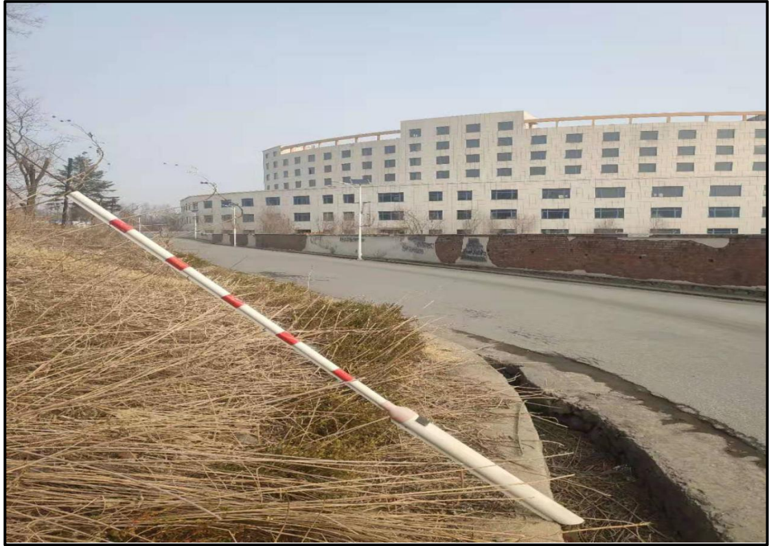
图 2.3-2 现场照片-办公楼
