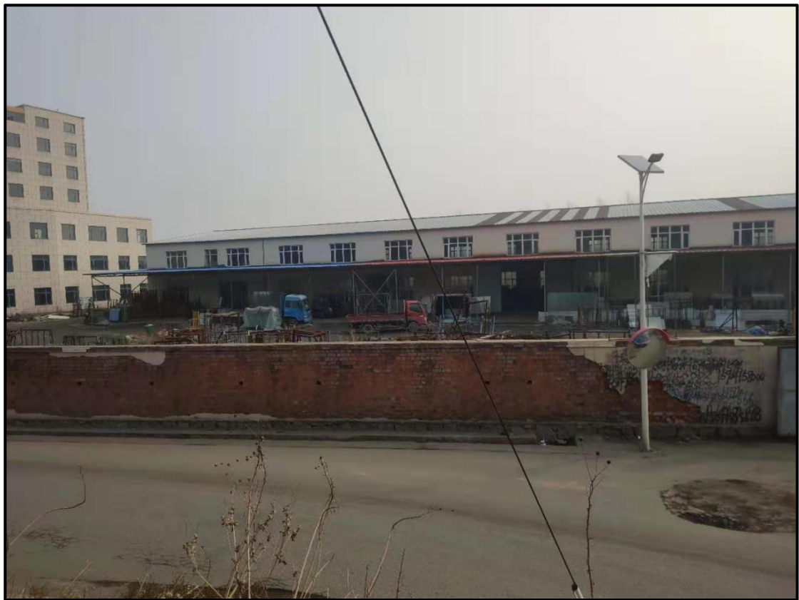
图 2.3-3 现场照片-厂房
