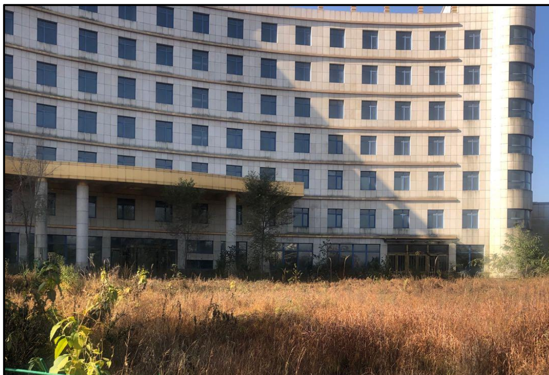
图 2.3-1 现场照片-办公楼
