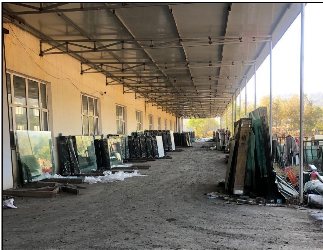
图 2.3-4 现场照片-厂房
