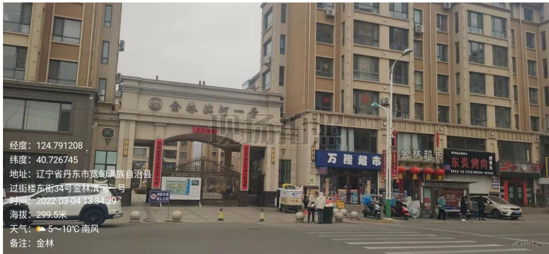
图 2.5-6 地块周边现状图（地块南侧金林滨河一号小区）
