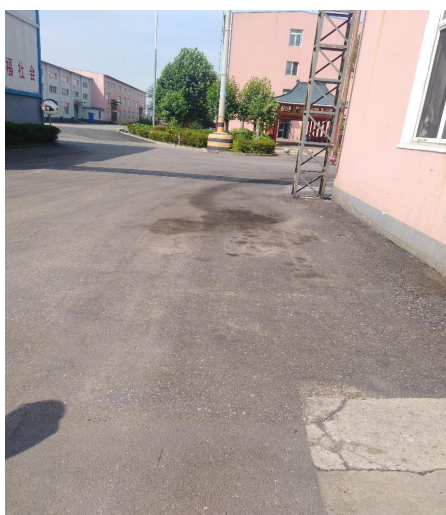
酸库北侧厂区道路
