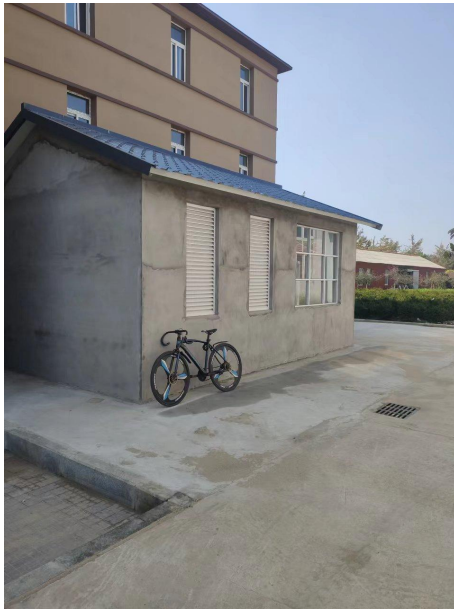
生活污水处理站
